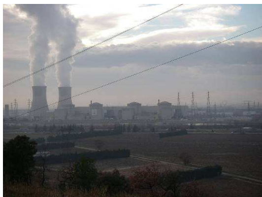
Tricastin - CNPE EDF et tours de refroidissement d'EURODIF
