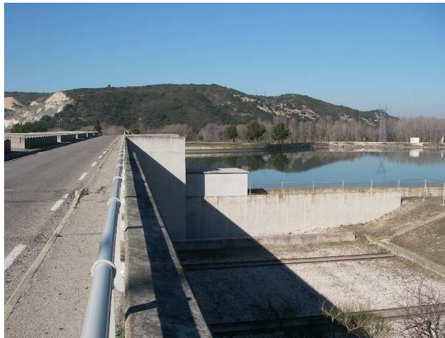
Local dans lequel est installée la balise aquatique
