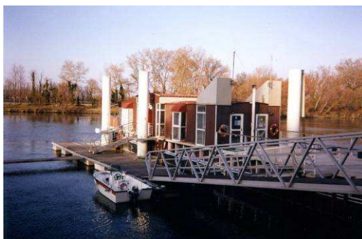
Péniche dans laquelle est installée la balise aquatique
