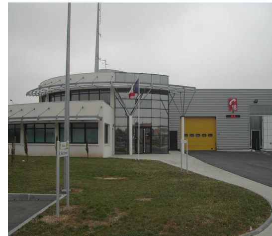
Caserne des sapeurs-pompiers de Romans
