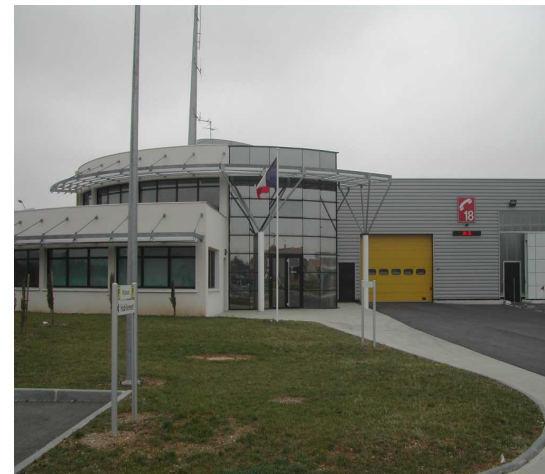
Caserne des sapeurs-pompiers de Romans
