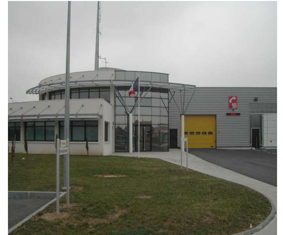
Caserne des sapeurs-pompiers de Romans
