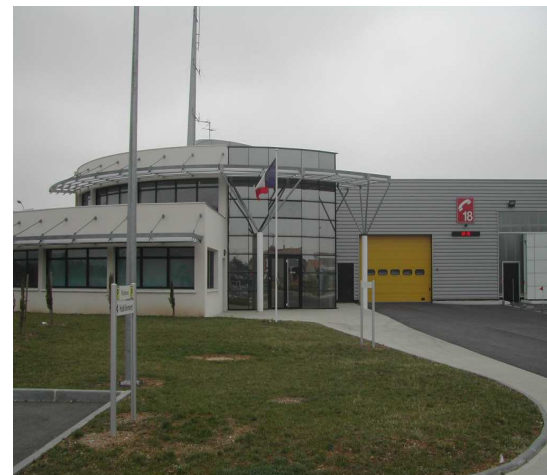
Caserne des sapeurs-pompiers de Romans
