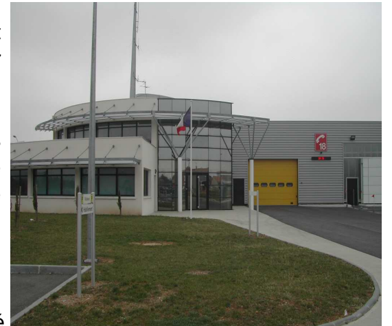
Caserne des sapeurs-pompiers de Romans
