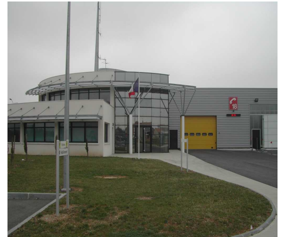
Caserne des sapeurs-pompiers de Romans
