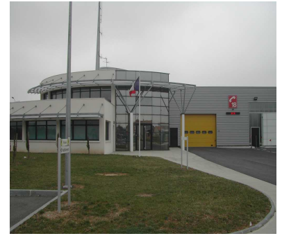
Caserne des sapeurs-pompiers de Romans
